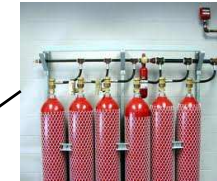
Supresión en cuartos eléctricos y de control
