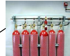
Supresión en cuartos eléctricos y de control
